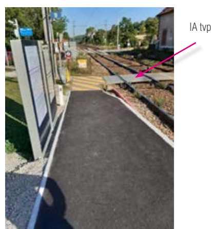
Figure 2 : Allongement de 10m en Voie 1 direction Province, Gare de Mareil-sur-Mauldre.
